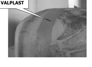
11) BEFORE INSERTING THE FLUE MANIFOLD, LAY SOME MORTAR VALPLAST ON THE LEDGE IN ORDER TO CREATE THE GASKET. THE HOLES ON THE TWO SIDE FLANGES ALLOW THE INSERTION OF THE SUITABLE DOWELS AFTER DRILLING THE OVEN'S MOUTH.
