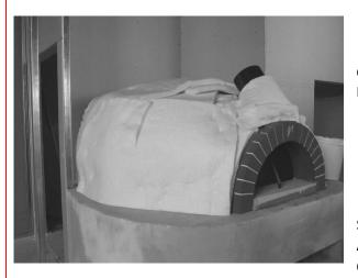
12)ONCE COMPLETED THE STOCCOING OF THE CROWN'S ELEMENTS, WRAP THE OVEN WITH A DOUBLE LAYER OF CERAMIC BLANKET.
